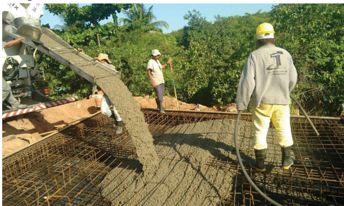
O serviço de concretagem começou na última terça-feira: a obra é orçada em R$ 700 mil e deve ser concluída num prazo de 60 dias
